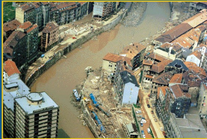
Foto: Efecto de las inundaciones en Atxuri. Bilbao. Agosto de 1983.
