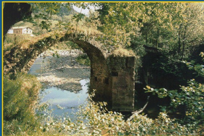
Puente de Amube sobre el río Ibaieder. Azpeitia
