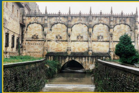
Oñati. Claustro sobre el Ubao
